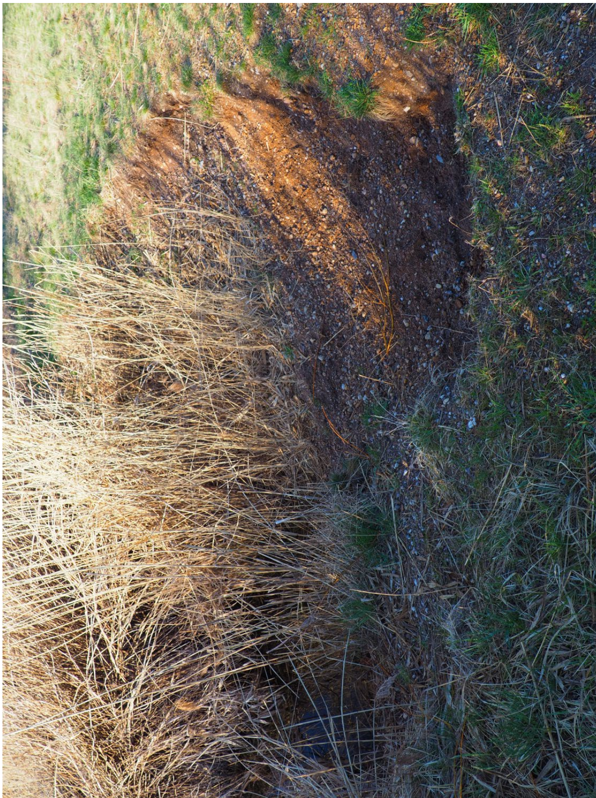
Ukázka ustupujících břehů rybníka.
