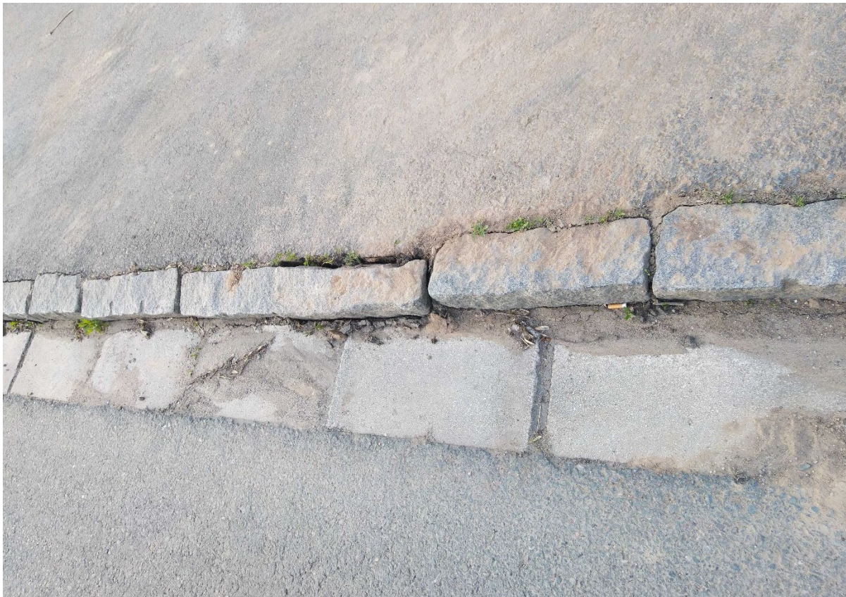
Chodník poškozený průjezdem těžké zemědělské techniky (foceno 29. 4. 2022)
